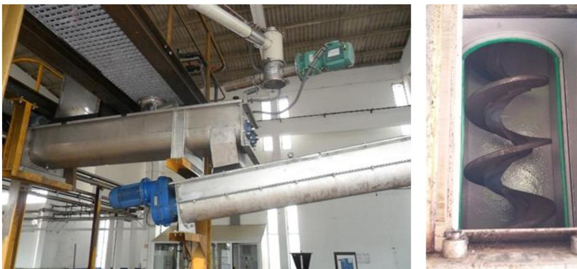
*Figura 32 - Reparação dos transportadores da desidratação de lamas da ETAR da Ribeira dos Moinhos*
