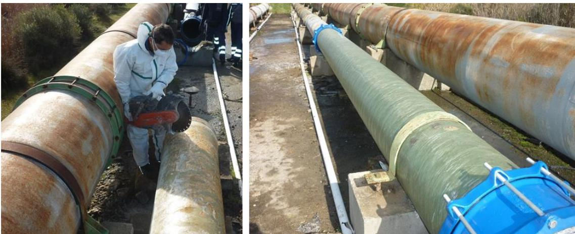
Figura 34 - Reparação da conduta adutora DN500 (troço aéreo) da Ribeira dos Moinhos para Monte Chãos
