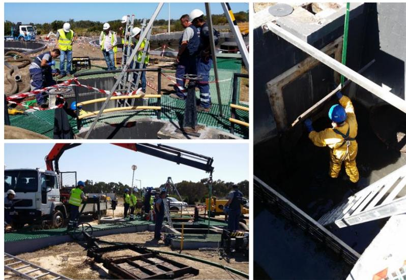
Figura 29 - Substituição das Comportas da ETAR de Ribeira dos Moinhos
