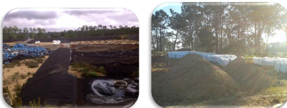
Figura 25 - Ecomparque RESIM de Santo André - Separação de Alvéolos na Célula de RIB
