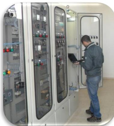
Figura 30 - Manutenção de quadros elétricos
