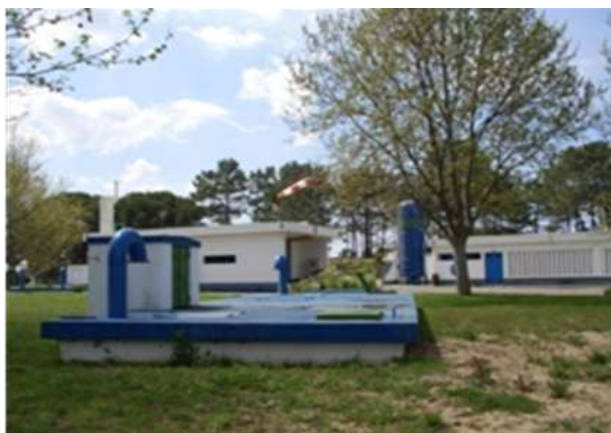
Figura 10 - Centro Operacional de Santo André
