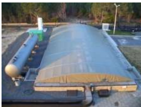
Figura 22 - Tanque de Remoção de Óleos e Gorduras
