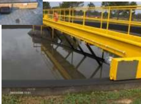
Figura 23 - Decantador Primário
