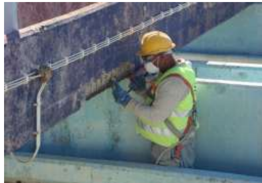
Figura 34 - Operação de Recuperação de Betões
