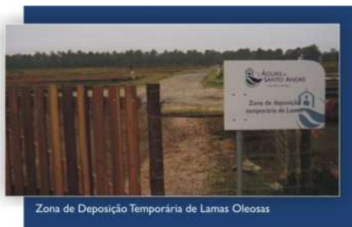
Figura 30 - Zona de Deposição Temporária de Lamas Oleosas
