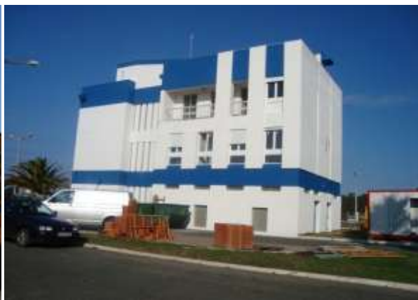
Figura 37 - Aspecto final após a 1ª Intervenção
