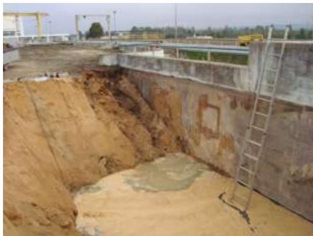
Figura 108 – Obras de Reparação na Câmara de Tranquilização
