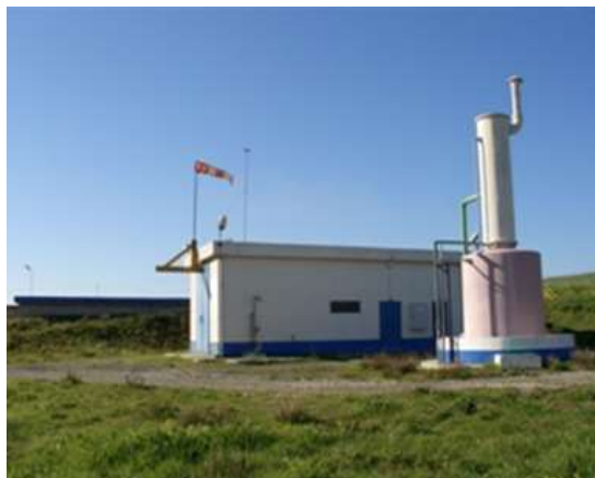
Figura 12 - Centro Operacional de Monte Chãos
