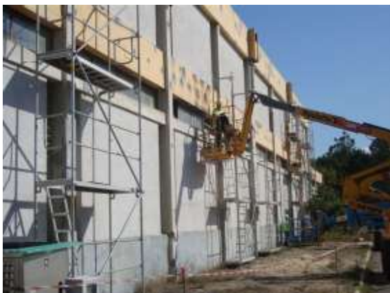
Figura 36 - Intervenções na Fachada do Edifício 2
