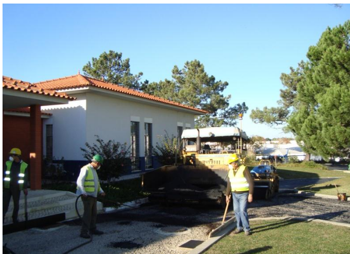
Figura 15 – Pavimentação do Recinto da Sede.
