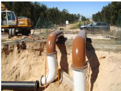
Ligação das novas condutas elevatórias à caixa de reunião existente
