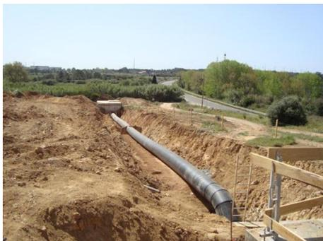
Ligação entre a rede existente da AdSA e a nova rede de água industrial construída pela aicep Global Parques
