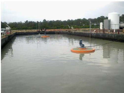
Tanque de homogeneização: oxidação através de sistemas ISO
