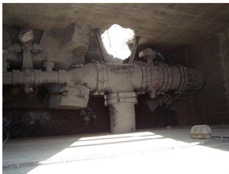
Intervenção na caixa da Repsol existente para interligação das condutas
