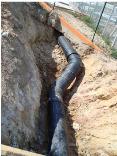
➤ **Conduta Provisória para Abastecimento à Refinaria da Petrogal – Execução das caixas de acessórios e ponto de medição de caudal**
