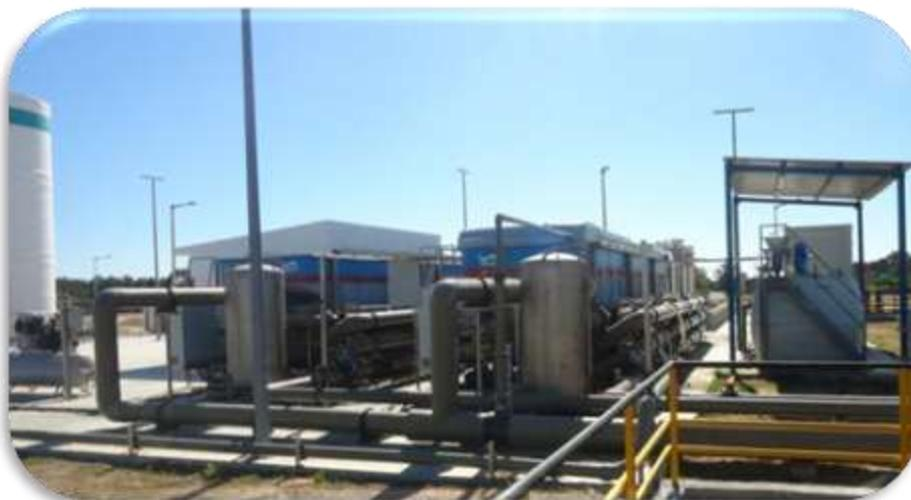
Figura 19 - Sistema de flotação de lamas por ar dissolvido
