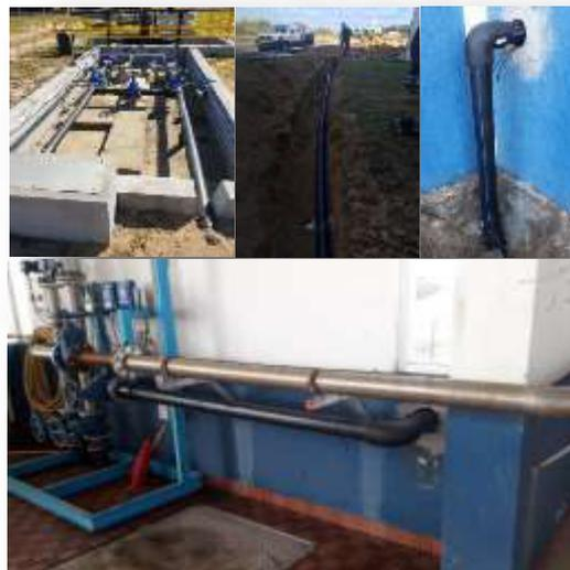
Figura 32 – Tubo de Bombagem de lamas do espessador para o edifício Centrifugas
