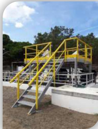
Figura 20 - Empreitada-“Execução de Proteção Coletiva em Diversas Instalações da Águas de anto André”
