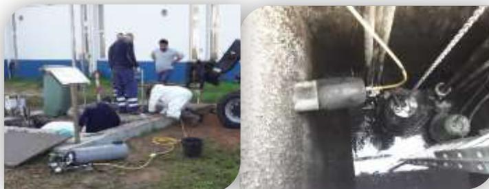
Figura 37 – Reparação de rotura no coletor PRFV DN500 ZIP3 – Caixa 41, a Sul da esteira da Repsol
