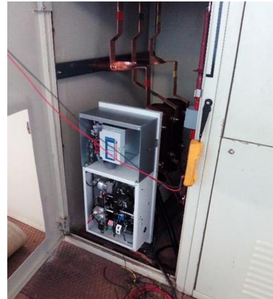
Substituição do disjuntor de proteção do transformador de baixa tensão da Estação de Ermidas
