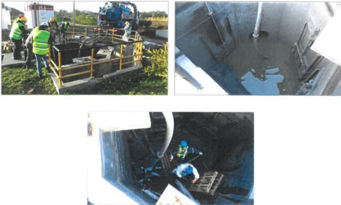
Figura 32 Reparação de rotura no coletor PRFV DN 1200 poço K da ETAR de Ribeira dos Moinhos
