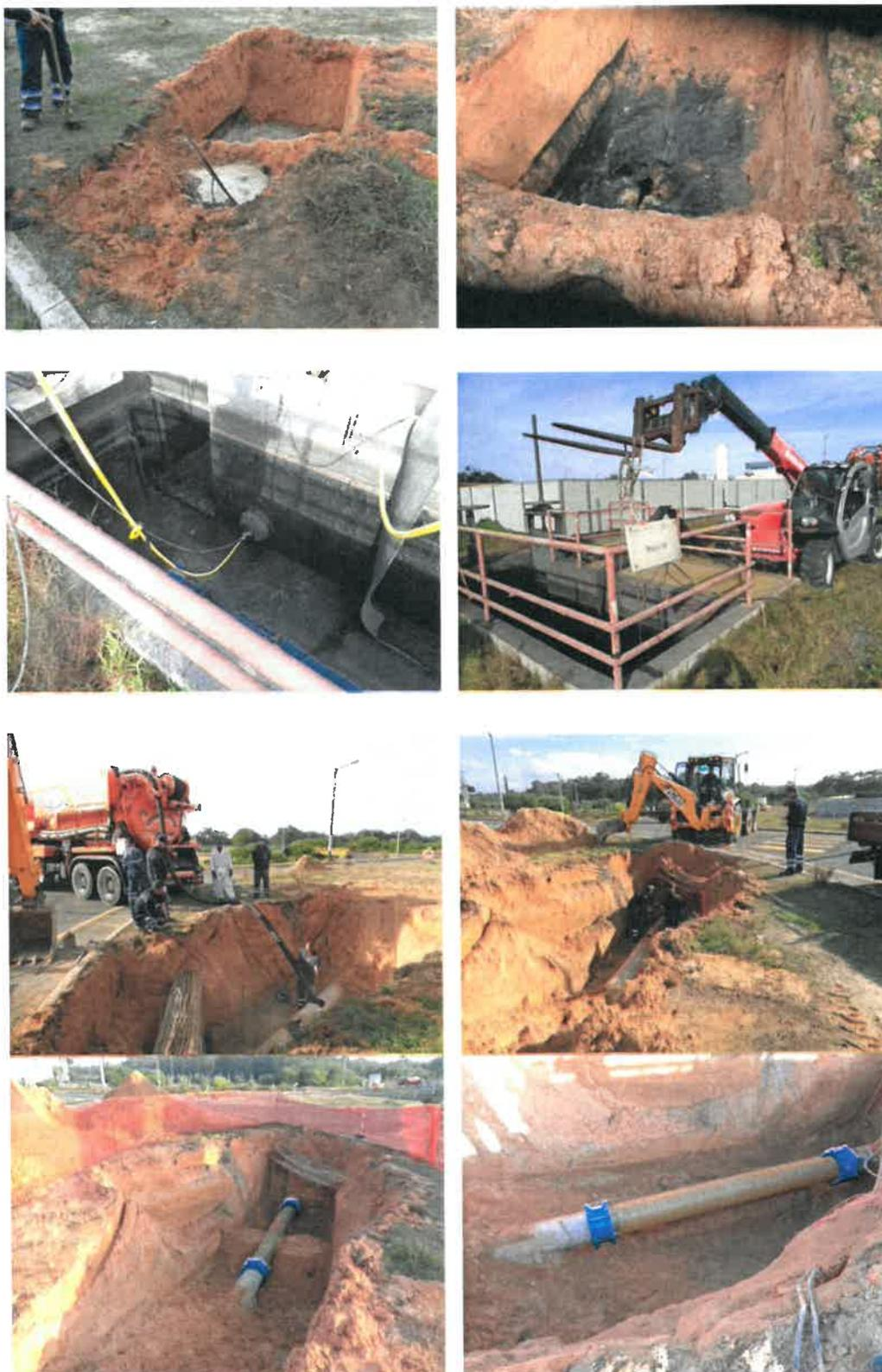
Figura 33 – Reparação da rotura no coletor PRIV DN 350 de recirculação de lamas da ETAR de Ribeira dos Moitinhos
