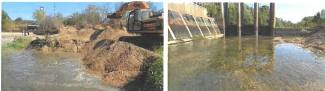
Figura 29 – Limpeza da Zona da Grelhas de Captação
