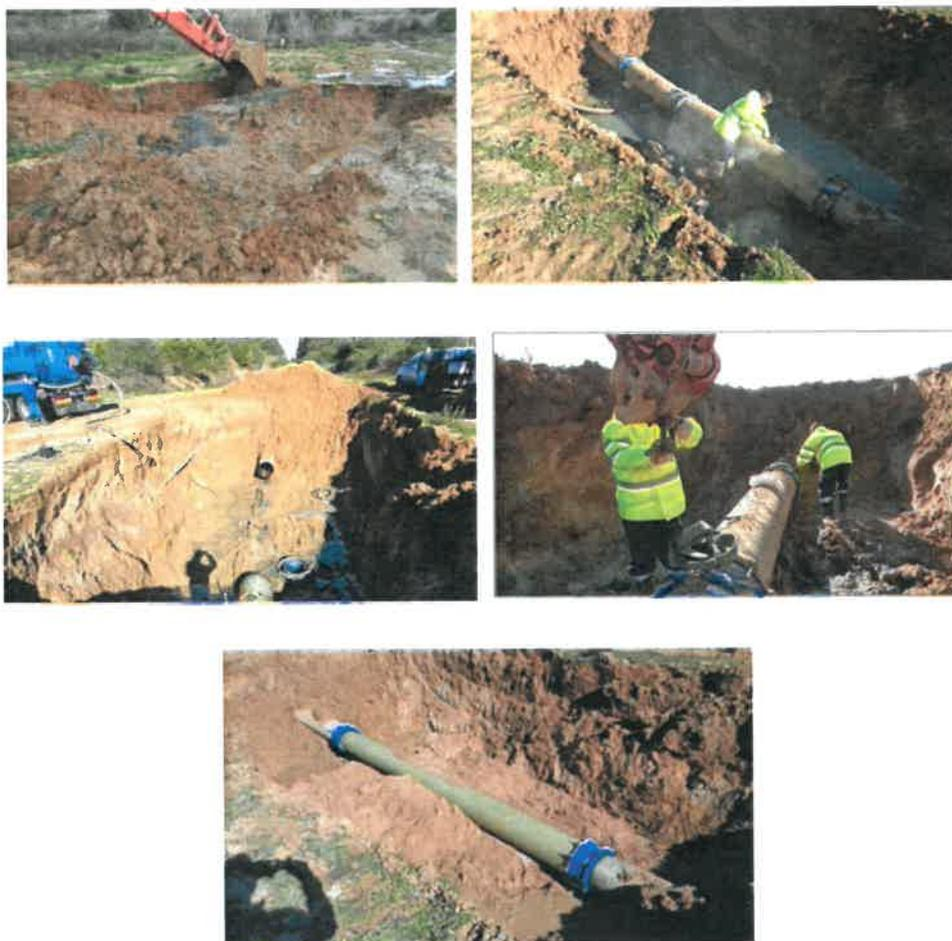
Figura 31 – Reparação de rotura no coletor PRFV DN500 ZIP3 – Caixa 41, a Sul da esteira da Repsol
