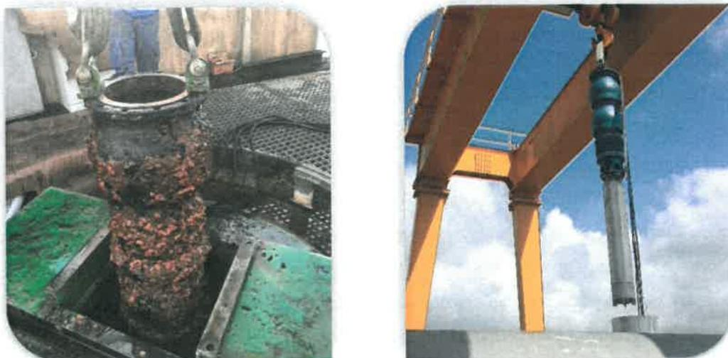
Figura 18 - Substituição de grupos eletrobomba - Captação Morgavel
