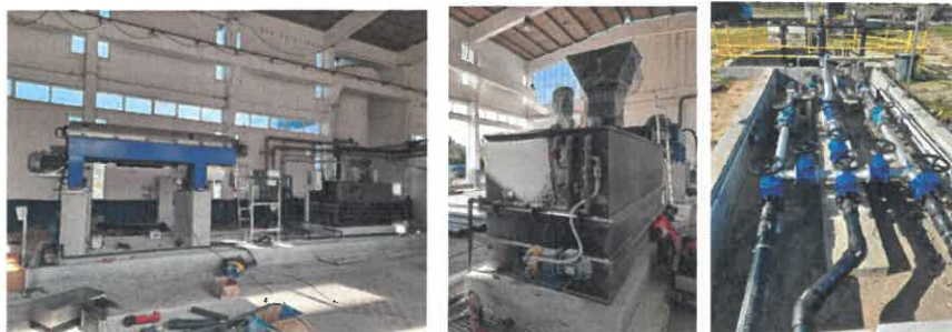
Figura 28 - Aquisição de sistema de desidratação da ETAR
