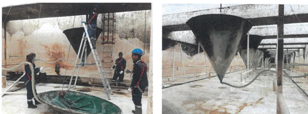
Figura 23 - Realibitação dos decantadores ETA
