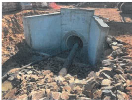
Figura 15 - Execução da empreitada de "Substituição de maciço de conduta"
