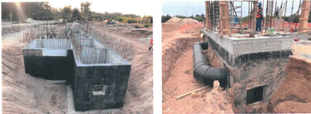
Figura 16 – Execução da empreitada de “Execução do Posto de Medição e Controlo de Efluentes Salinos”
