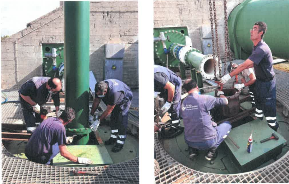
Figura 24 - Instalação de bomba no poço de bombagem
