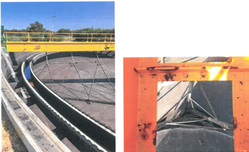
Figura 25 - Manutenção preventiva do decantador secundário nº2 da ETAR de Ribeira dos Moinhos
