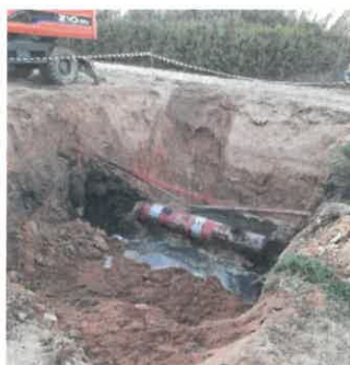
Figura 26 - Reparação de 2 roturas AR
