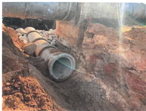
Figura 15 - Execução da empreitada de "Substituição de maciço de conduta"
