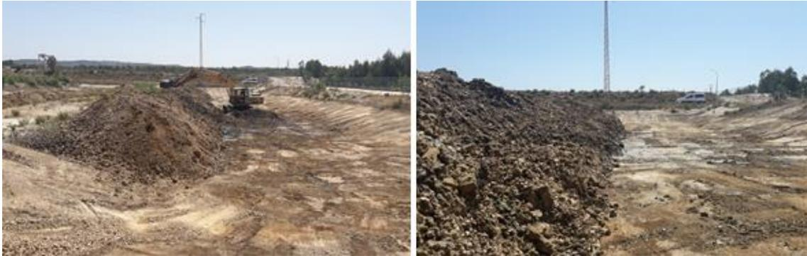
Figura 25 – Leitos de Secagem de Lamas da ETA de Morgavel
