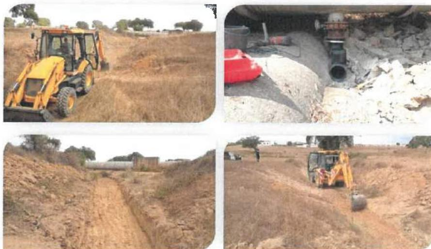
Figura 41 – Beneficiação de duas descargas de fundo da conduta adutora Ermidas-Sado
