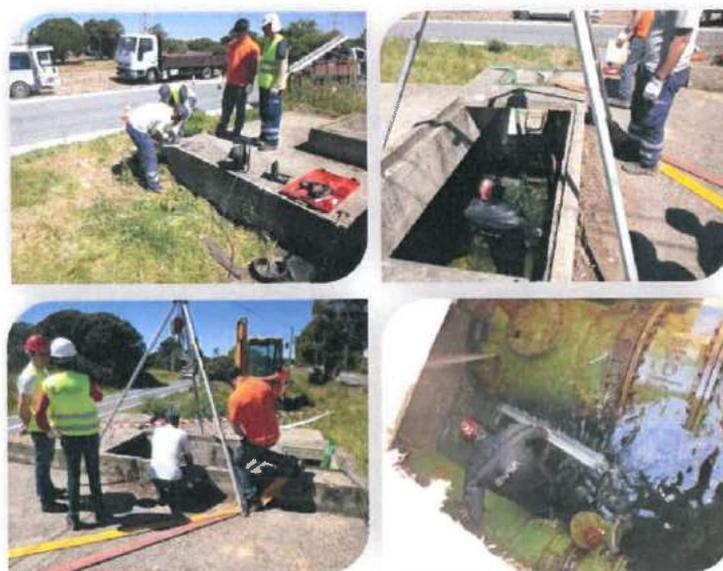
Figura 39 – Reparação de uma rotura na conduta adutora ETA – Monte Chãos
