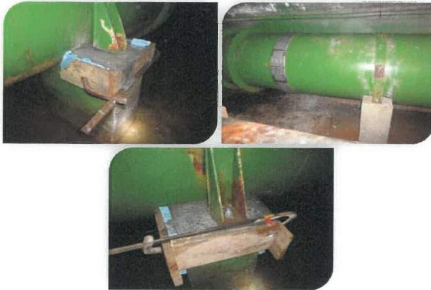
Figura 37 – Reparação da rotura na conduta adutora ETA – Monte Chãos
