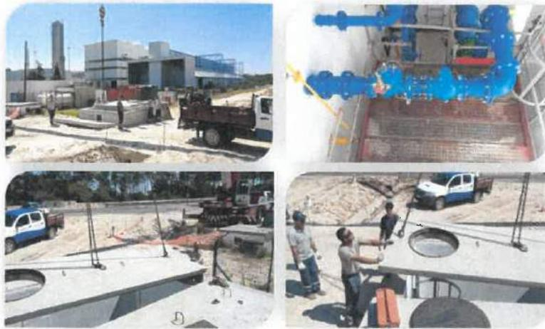
Figura 40 - Instalação de válvula redutora
