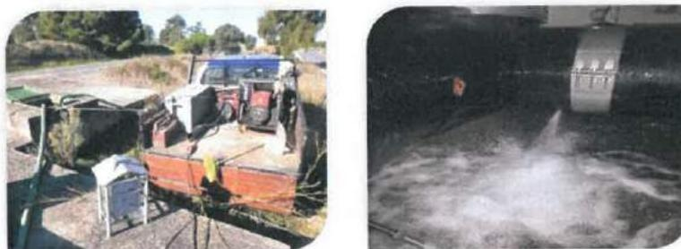
Figura 35 – Reparação de rotura na conduta adutora ETA de Morgavel/Monte Chãos
