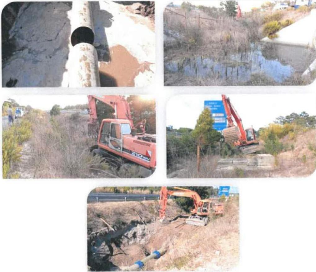
Figura 42 – Reparação de rotura na conduta adutora COSA – EE Ribeira dos Moinhos
