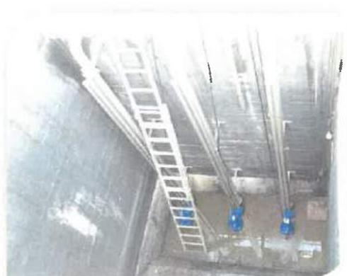
Figura 29 - Reabilitação da Estação Elevatória de Extração de Lamas da ETAR de Ribeira de Moinhos
