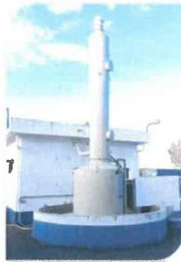
Figura 28 - Remodelação dos Sistemas de Neutralização de Fugas de Cloro das ETA
