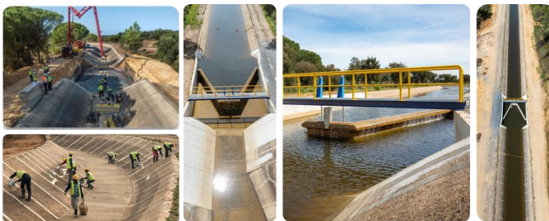
Figura 45 – Execução da empreitada do “Reabilitação do Canal de Ermidas”
