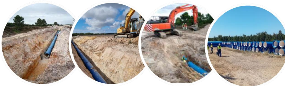
Figura 47 - Empreitada de "Conduta Adutora entre a ETA de Morgavel e o Reservatório de Monte Chãos"
