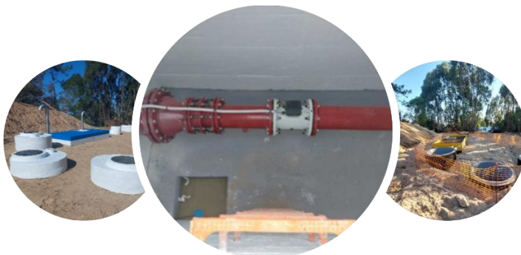
Figura 46 - Execução da empreitada de " Execução da caixa de medição de caudal, ARU, na Barbuda"
