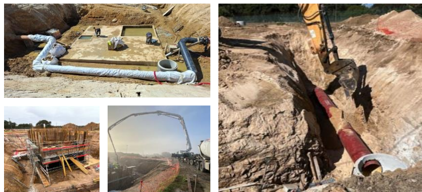
Figura 48 - Empreitada de Execução “Emissário da Petrogal à bacia da ZIP 3 e Bacia de Retenção ZIP3”
